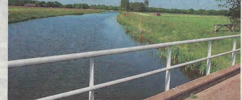
In het dynamische Twentse landschap is een speciaal Dinkelkanaal, het Omleidingskanaal, aangelegd om omvangrijke overstromingen te voorkomen.
